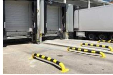
*Ilustración 46 Guías y marcas para camiones*
