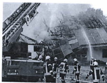
Figura 6 Incendio en una Central Eléctrica Fotovoltaica con daños en la estructura del inmueble
