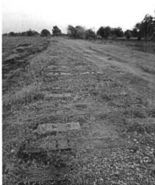
Figura 17. VÍA CONCESIONADA FUERA DE OPERACIÓN. Vía fuera de operación, desde el kilómetro 76+000. Línea VB 076+000 al 101+000.
