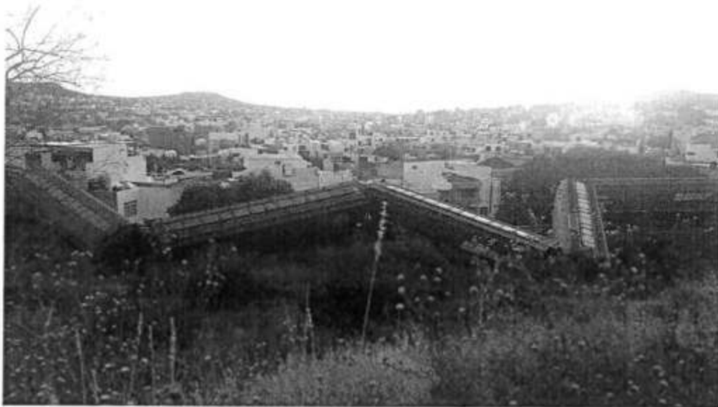
Fig.26. Choque por autorización de vía no respetado PK A 700+000
