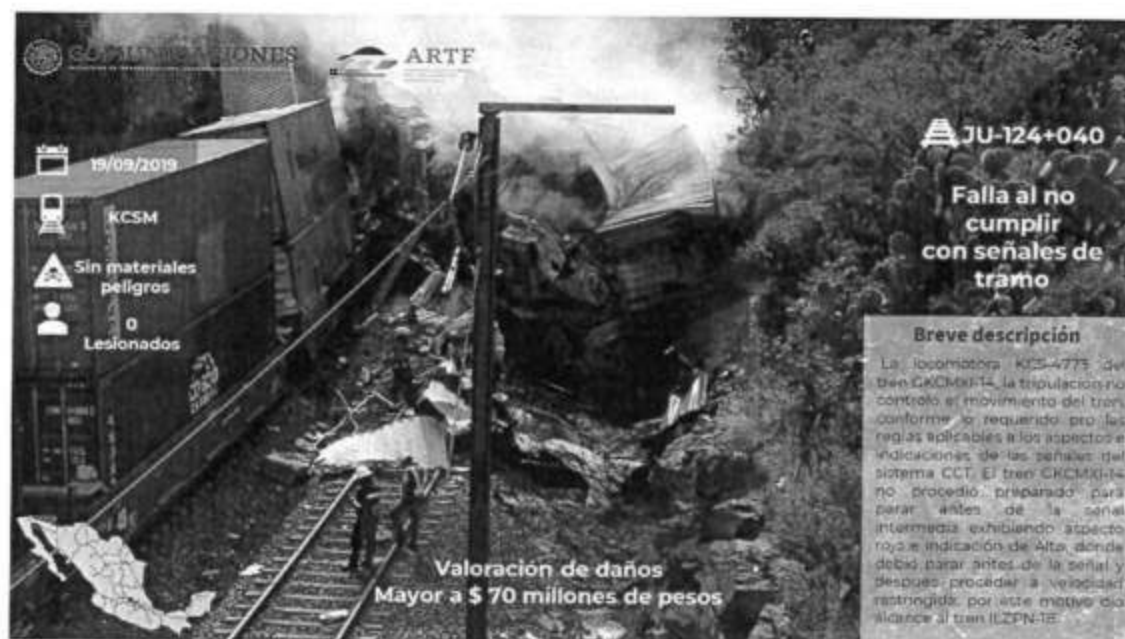
Figura 29.- Falla al no cumplir con señales de tramo
