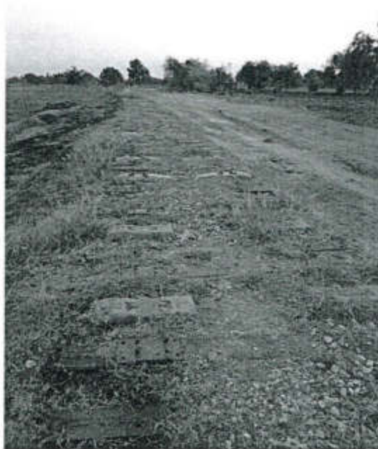
Figura 17. VÍA CONCESIONADA FUERA DE OPERACIÓN. Vía fuera de operación, desde el kilómetro 76+000. Línea VB 076+000 al 101+000.
