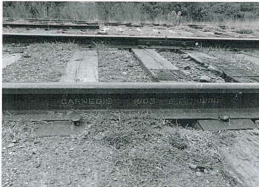
Figura 9. RIEL ANTES DE 1995 (1905) diferentes calibres de 75 a 110 lbs/yd y diferentes años siendo el más reciente del año 1945. Línea H 18+917 al 66+150
