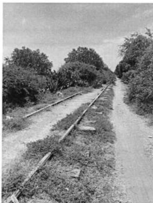
Figura 16. VÍA CONCESIONADA FUERA DE OPERACIÓN. Vía fuera de operación, desde el kilómetro 26+800. Línea AB 026+800 al 069+594
