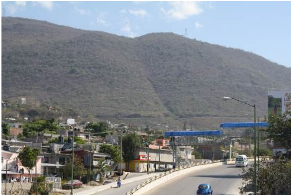
Infraestructura desarrollada en los límites con ecosistemas en buen estado de conservación, región de miradores, CONANP febrero 2012.
