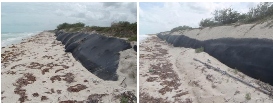
Figura 31. Condiciones de la playa en Las Coloradas con el geotubo expuesto en la zona de anidación previo al inicio de la temporada reproductiva, en marzo de 2013.
