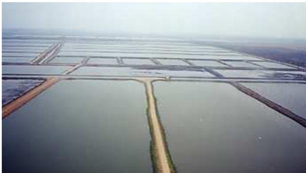
escaso. Para la construcción de los estanques, el suelo se distribuye y coloca formando taludes, retirándolo desde los fondos y acomodándolo hacia los costados. La profundidad deberá ser uniforme. En general se construye un área externa que se utiliza para la cosecha, adyacente a los estanques o bien, se pueden emplear trampas a las cosechas,
