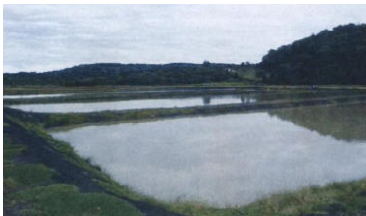
Figura 3: Estanques excavados en tierra
