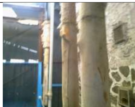
ASLAMIENTO TERMICO DE TUBERIA
