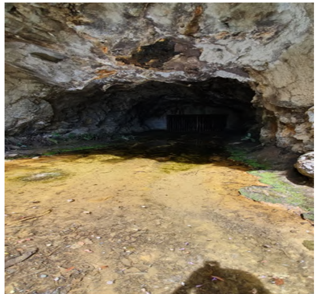
Inspección en minas
