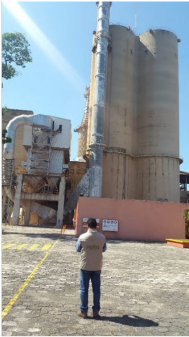
Instalación de jurisdicción federal
