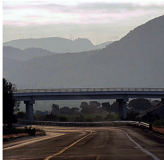
Construcción de puentes y distribuidores viales
