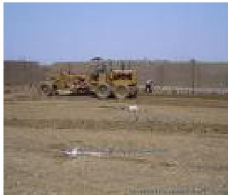
Fig. 3.1 Nivelación del terreno
