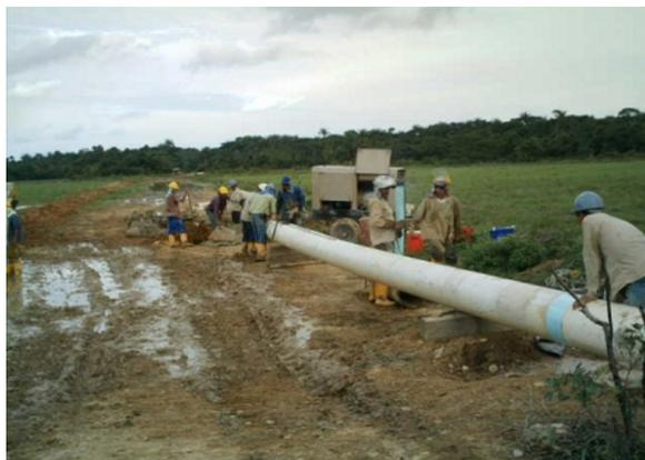
Fig. 3.3 Tendido de la tubería
