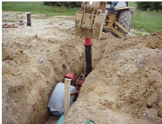
Fig. 3.2 Excavación de una zanja
