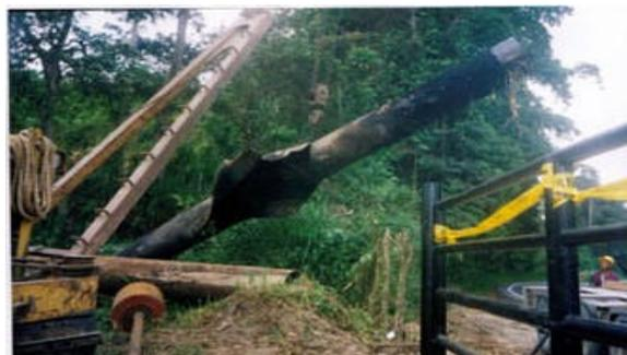
Figura 1.7. Rotura del ducto por excavación en Quininde, 30-oct-2000
