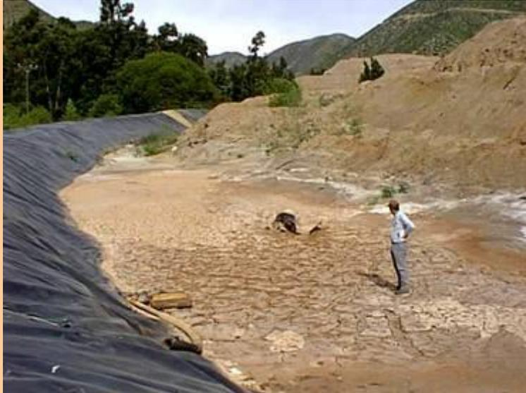
Foto 5.- Impermeabilizado basal de escombrera.
