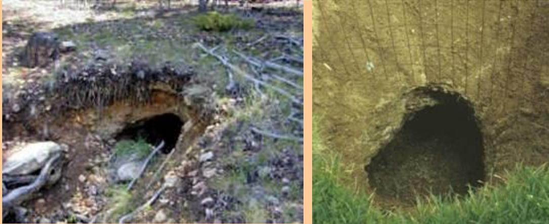
Fotos 3a (izquierda) y 3b (derecha), que muestran una embocadura de galería colapsada, y un pozo formado por colapso de una galería de escasa profundidad.
