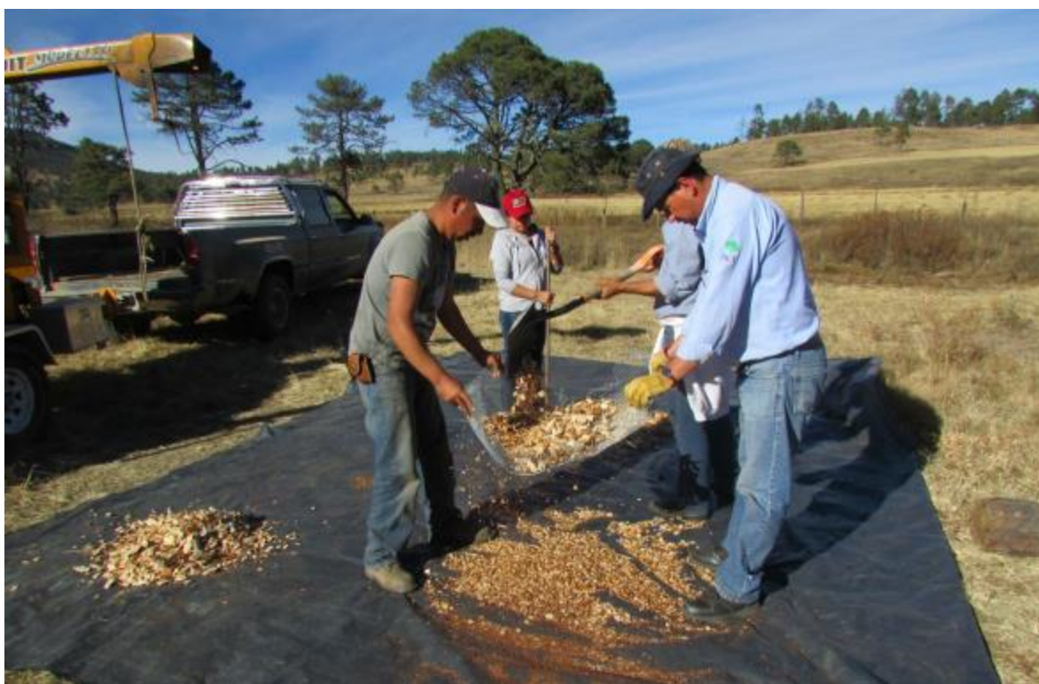
Figura 22. Tamizado del material para separar tamaños de partículas.
