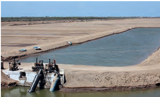
Granja acuícola en operación
