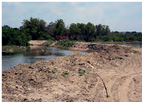
Extracción de material pétreo
