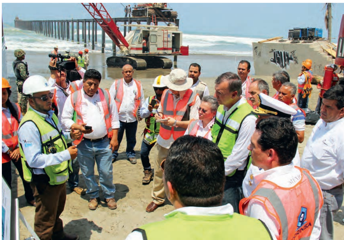
Arranque de los trabajos para el retiro del muelle en Playa Revolcadero
