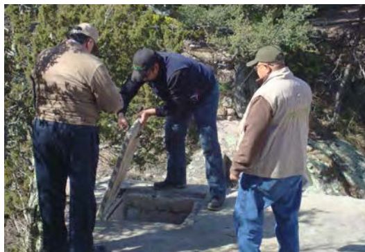
Verificación descarga de aguas residuales
