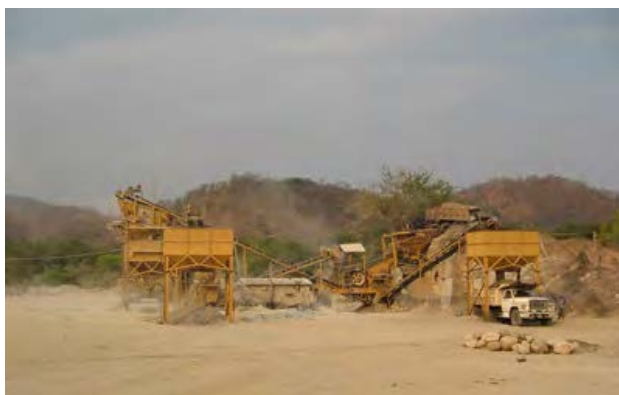
Almacenamiento de material pétreo extraído
