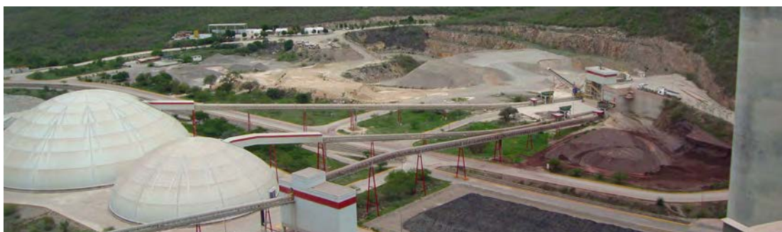
Instalación de jurisdicción federal
