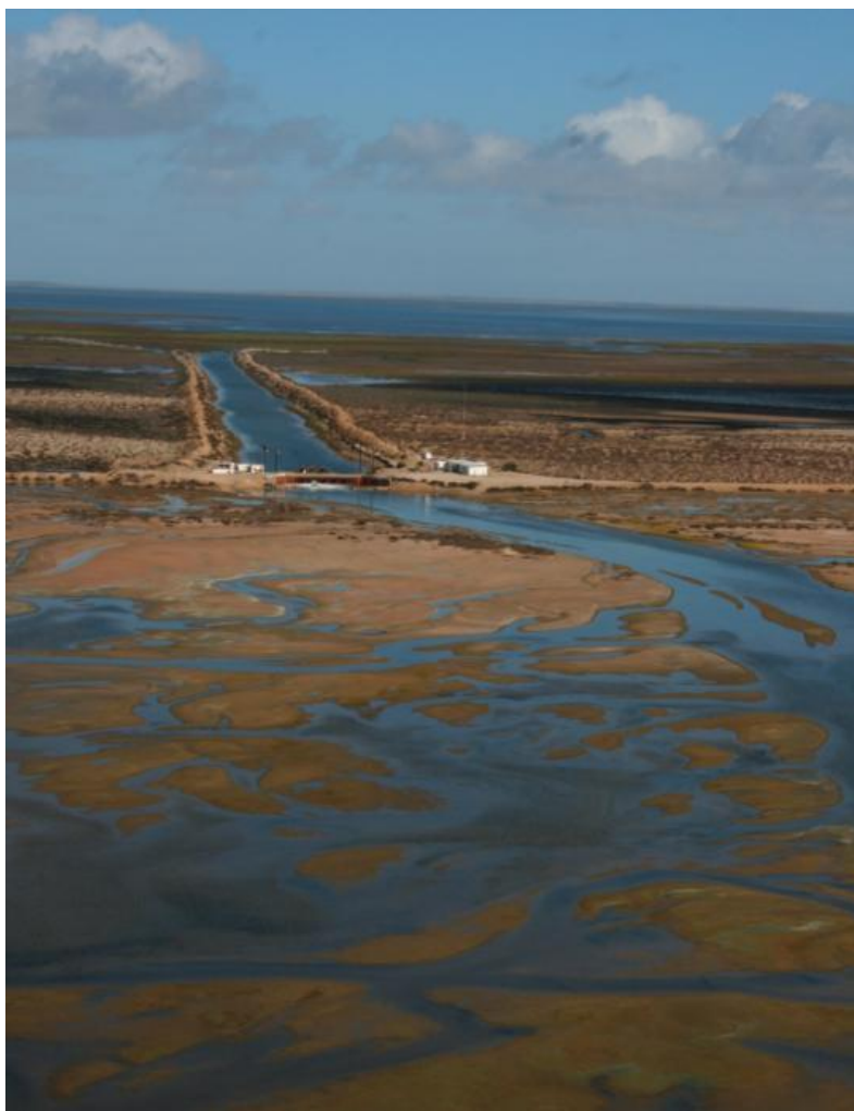
Figura 11. Vista aérea de un área artificial para la producción de sal en Guerrero Negro (S1-A). Se observa la estación de bombeo y las bombas en operación. Nótese el canal de llamada y el de entrada al sistema.
