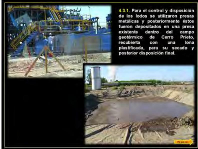
4.3.1. Para el control y disposición de los lodos se utilizaron presas metálicas y posteriormente éstos fueron depositados en una presa existente dentro del campo geotérmico de Cerro Prieto, recubierta con una lona plástica, para su secado y posterior disposición final.
