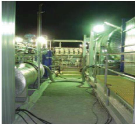
Figura 6.6. Equipos de tratamiento del agua de retorno en Marcellus Shale.
